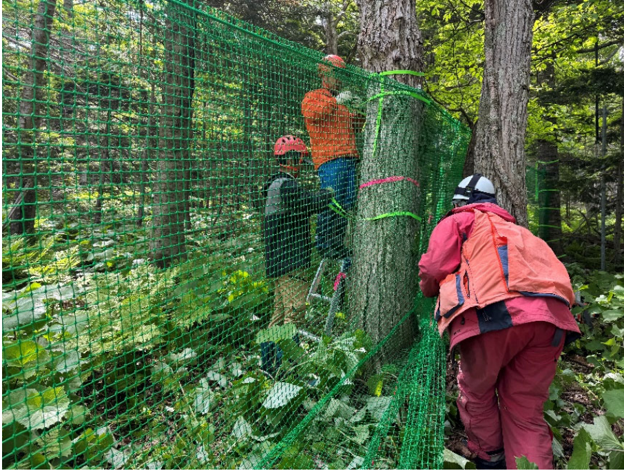
写真Ⅱ-9. グリーンネットの設置作業の様子（2025年6月3日）
