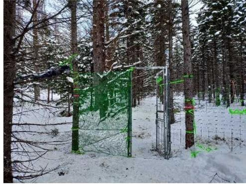
右：写真 1-33. シカの進入口及び閉鎖部となる二段式扉の片開きマンゲート
