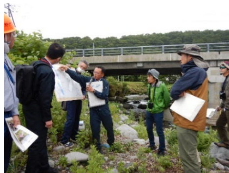
オッカバケ川橋梁補修の検討
