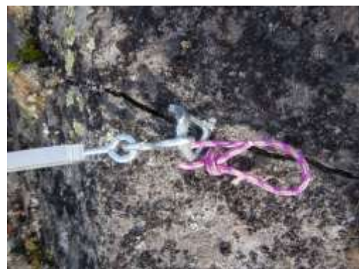
写真15：ワイヤーのアンカーは、リングボルト（写真左）並びにハーケン（写真右）で岩場にしっかりと固定した
