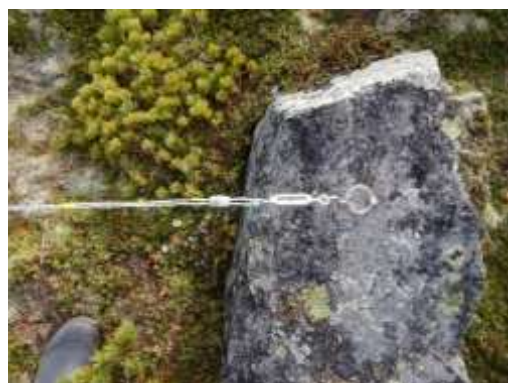
写真15：ワイヤーのアンカーは、リングボルト（写真左）並びにハーケン（写真右）で岩場にしっかりと固定した
