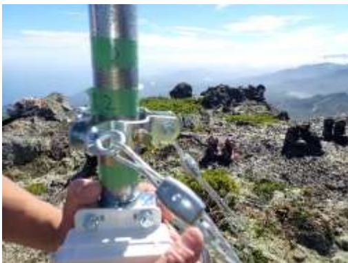
写真14：トリポットを設置した状態（写真左上）、マストをトリポットにはめて固定した状態（写真右）、マストをワイヤーで固定している様子（写真左下）
