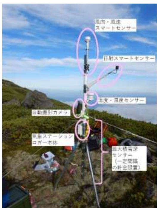
写真 16：気象ステーション本体に各気象観測機器を設置した様子
