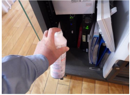
機器本体の清掃状況
