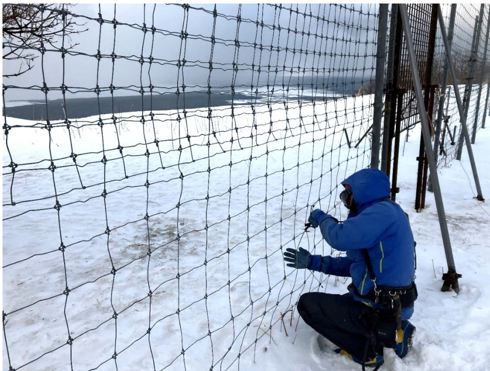
写真 1-3. 仕切柵の破損箇所を修繕する様子（2月14日）
