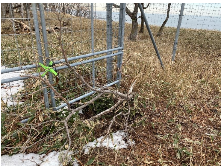
写真 I-23. 日常的な点検で発見した積雪下から現れた隙間を枝で応急的に塞いだ様子（2022年4月15日撮影）
