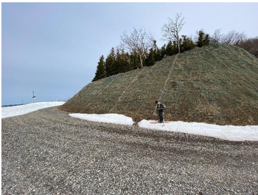
写真II-19. 現地調査における積雪の状況（2022年4月15日撮影）
