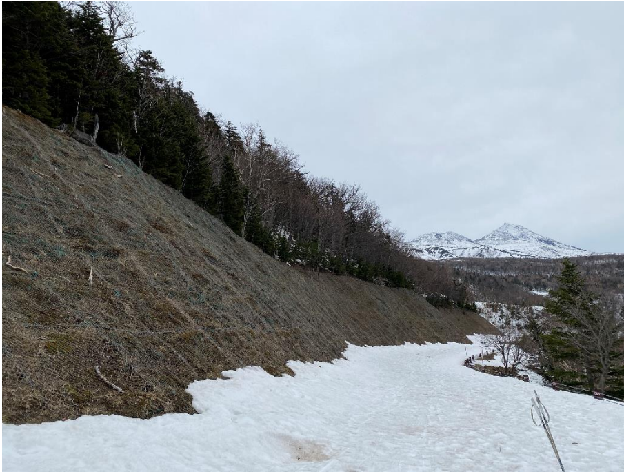
写真 II-20. 融雪によって露出した法面と積雪に覆われた路面（2022年4月15日撮影）
