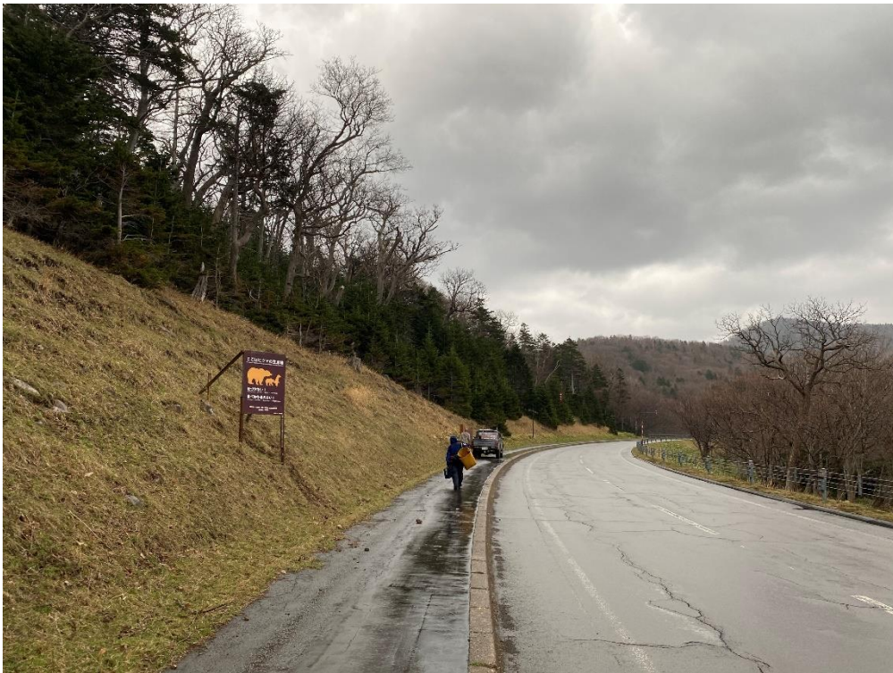
写真 17. 国道 334 号幌別橋付近に設置したヒグマ生息地看板（表 7 の No. 6, A 型）
