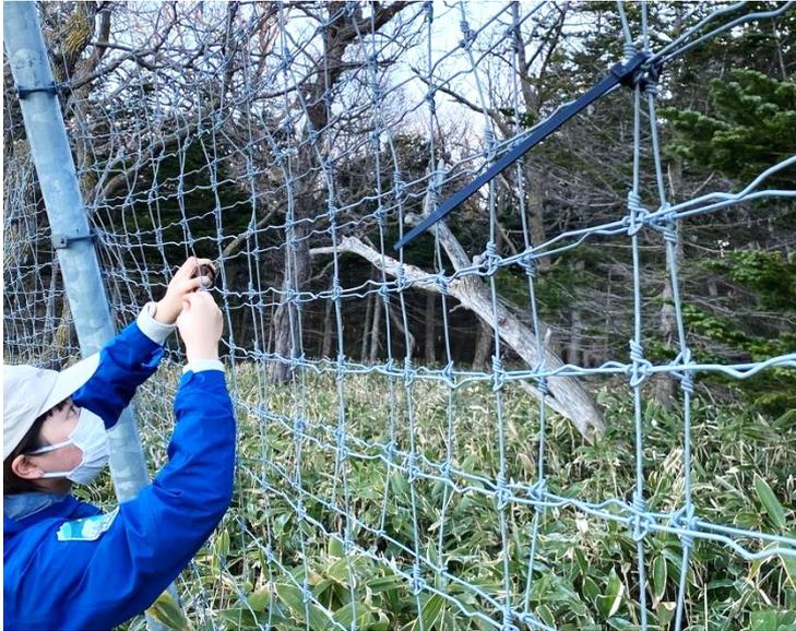
写真 1-7. フェンスの歪みにより生じた隙間を結束バンドで簡易的に補修する際の様子（2021年12月9日撮影）
