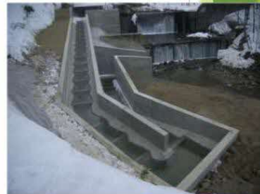
第2ダム改良直後
