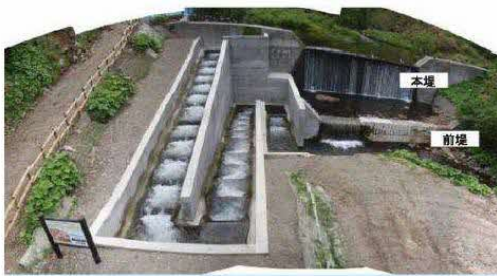
第1ダム改良直後
