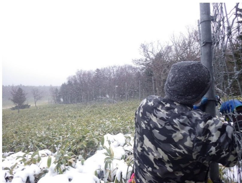
写真1-6. フェンスの隙間をロープで簡易に補修する際の様子(2020年12月4日撮影)
