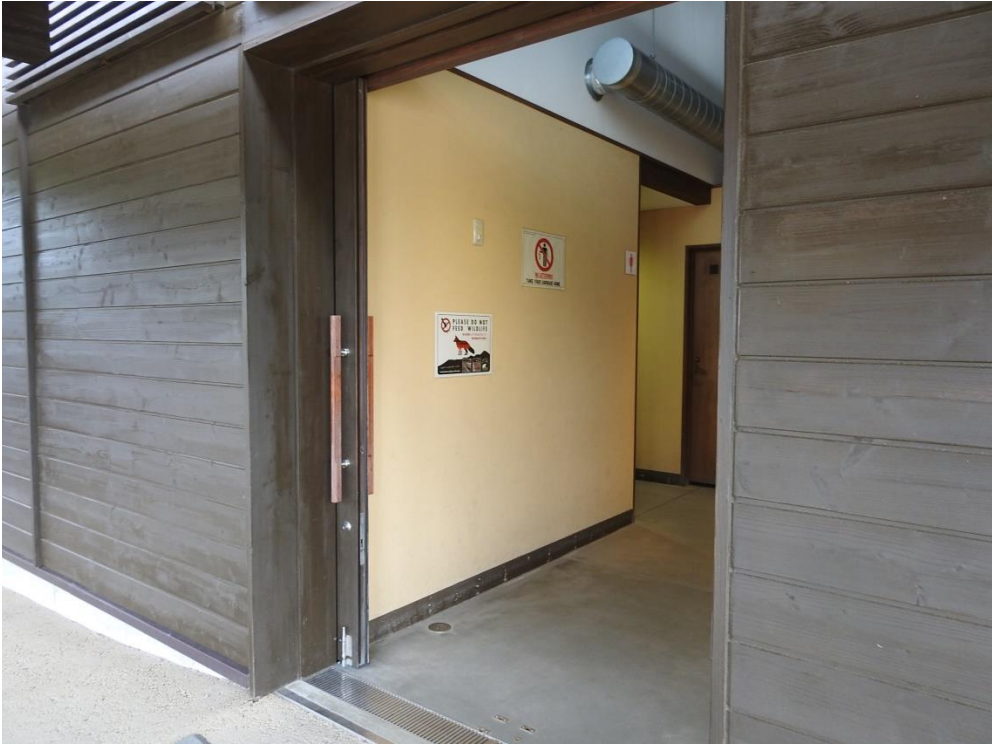
写真 13. 五湖 FH のトイレ入口に張り紙を掲示した状況
