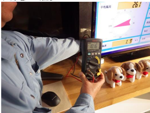
入力電圧の確認
