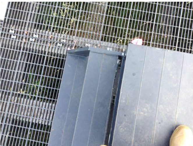
図8-1.アヤマ原地点 2019/08/11 調査地点周辺
