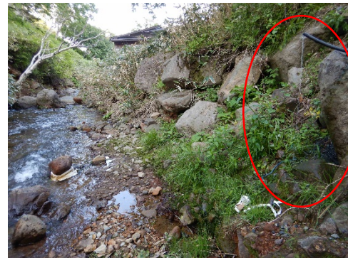
排水混入状況
