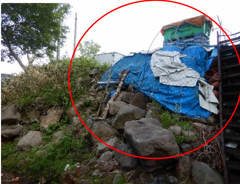
排水混入状況
