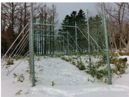
写真 A-1-2. 捕獲部の撤去跡を金網で塞いだ箇所
