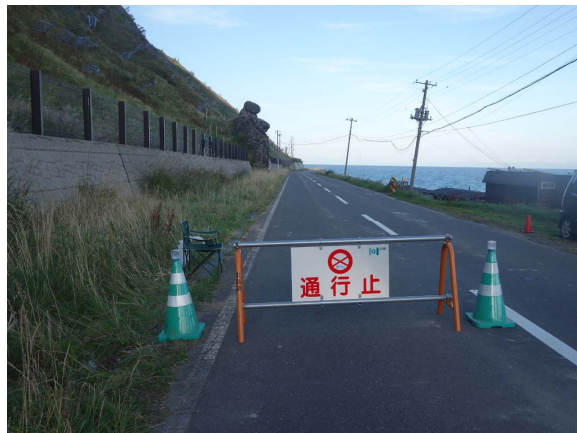
土砂崩れによる道道の通行止め（9/30・北浜）
