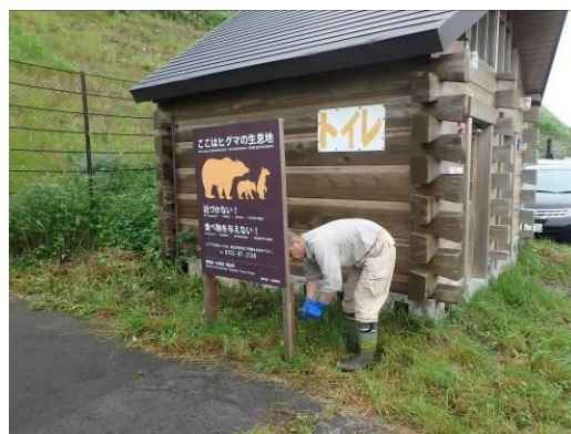
写真 1-34. セセキパーキングに型Bの看板を設置する当財団職員
