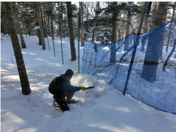
写真 C-3. 倒木により裂けた箇所を獣害防止ネットで修復している (平成 29 年 3 月 8 日撮影)
