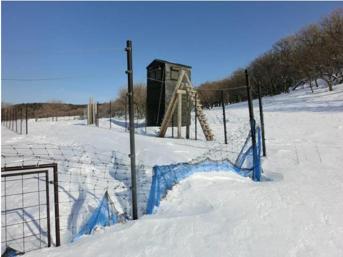
写真 C-1. 雪の重みで仕切柵の金網部分が下がった箇所 (平成 29 年 3 月 8 日撮影)
