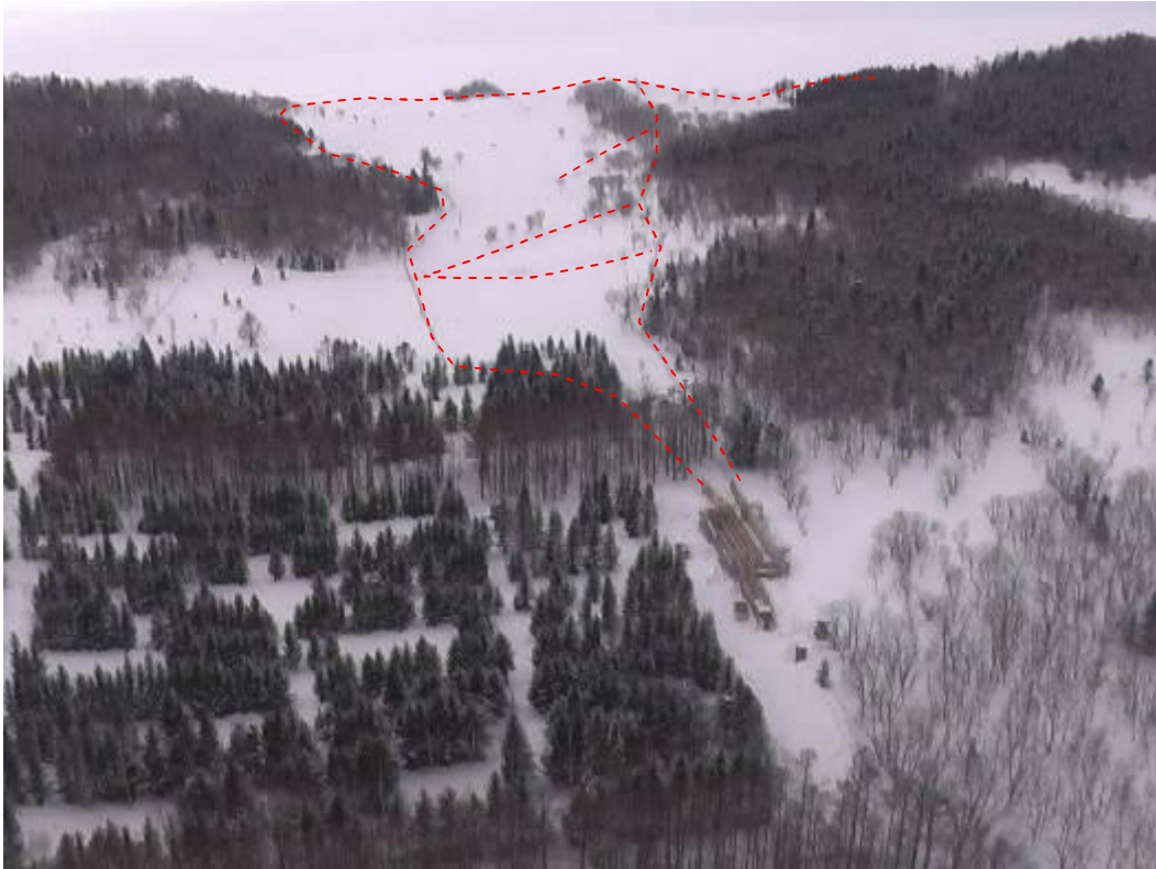
写真 A-1-1. 仕切柵の全容（3月4日撮影、赤破線が柵の設置位置）
