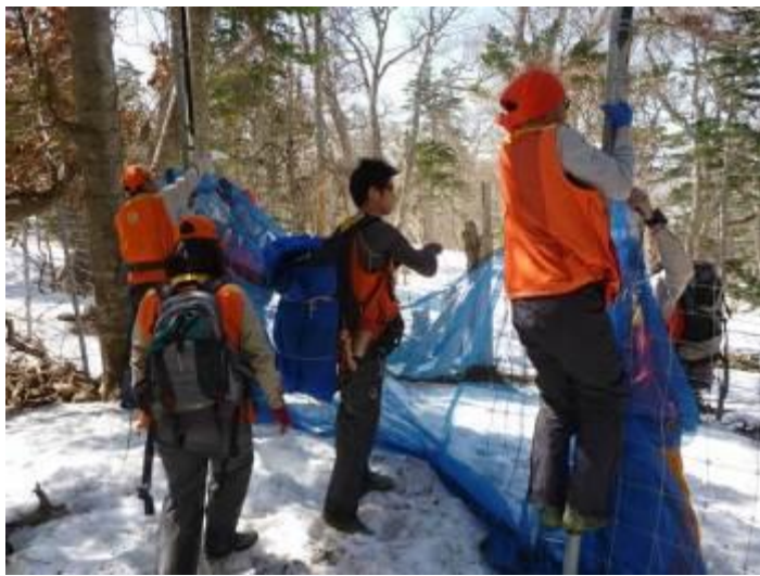
写真 C-3. 仕切柵の破損箇所を補修する様子（平成 26 年 4 月 30 日）
