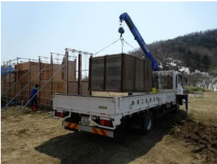
写真 B-1-3. 移送用ケージを搬出口に設置している様子.
