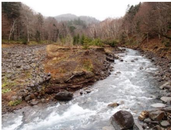
赤イ川No.13 鋼製えん堤上流 (H25/11/22)
