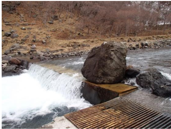
捕獲場えん堤上に流下・堆積した巨石（直径 1.6m）（H25/12/3）
