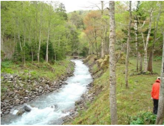
赤イ川No.12 鋼製えん堤上流 (H25/6/5)
