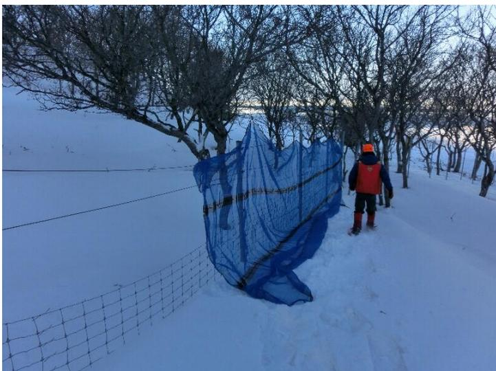
写真 3. 積雪により嵩上げが必要となった仕切り柵
