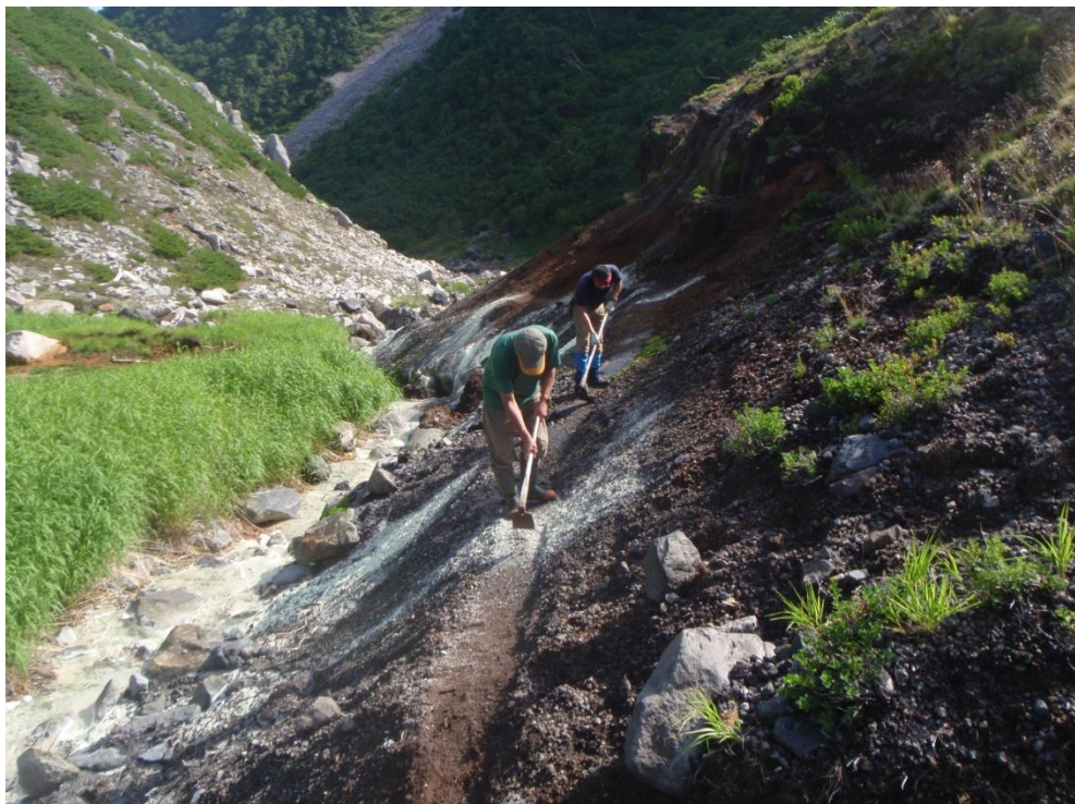
8 / 1 9 泊場周辺の路面傾斜部の修復
