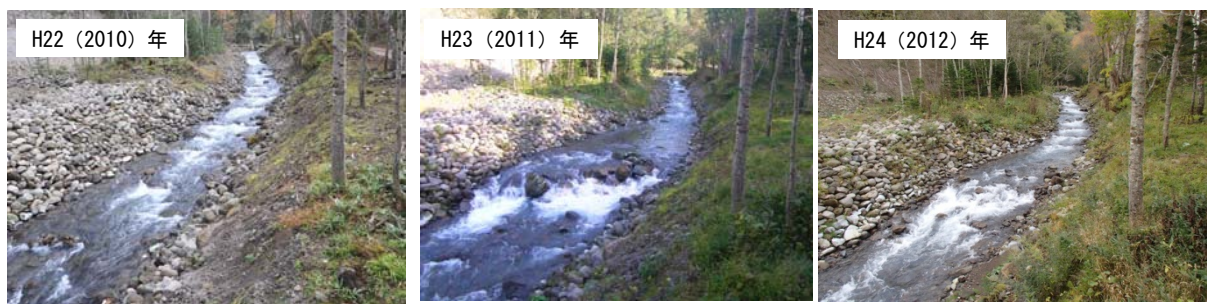
写真 6.8 SP20 (No. 12 鋼製えん堤上流部) の状況
