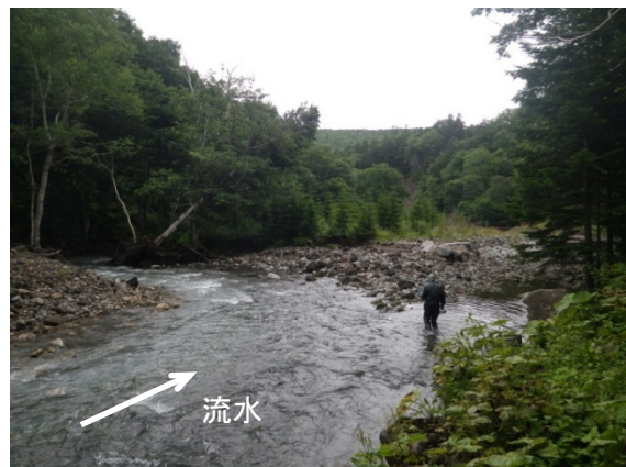
写真 6.9 DSP120 (No. 13 鋼製えん堤上流部) の状況
