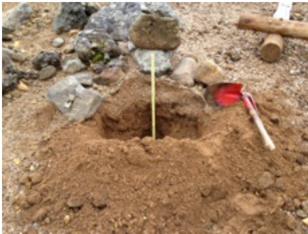
作業中。40 c mまで掘り込み
