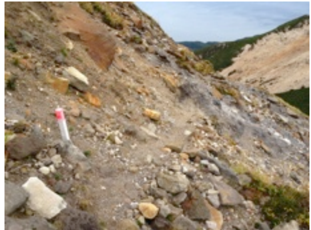
木杭 打ち込み後。縦走路分岐の大岩分岐側に2本、 硫黄分岐側に1本を打ち込み
