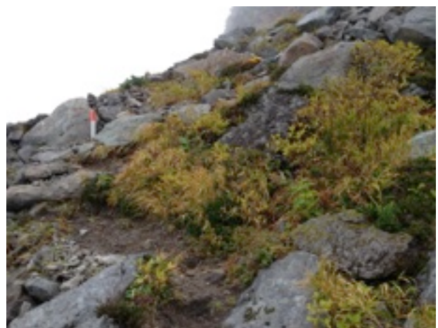
木杭 打ち込み後。縦走路分岐から山頂方向に13本 を打ち込み
