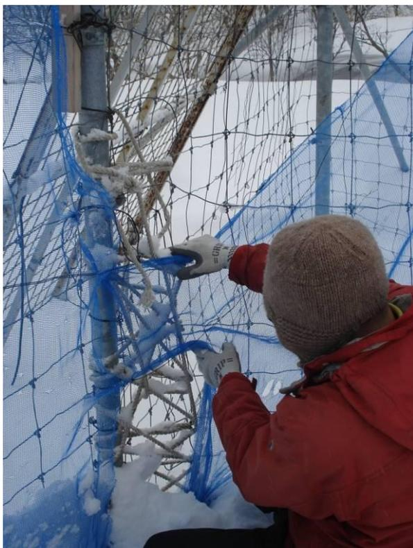
写真 B-1-11. エゾシカの激突によって破損した金網の修繕.
