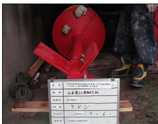
④ケレン作業中
