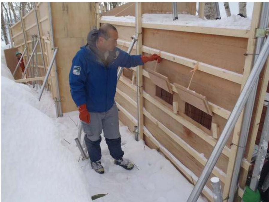
図 B-3-4. 仕切部屋（暗室）の側面に設けた作業用の窓.
