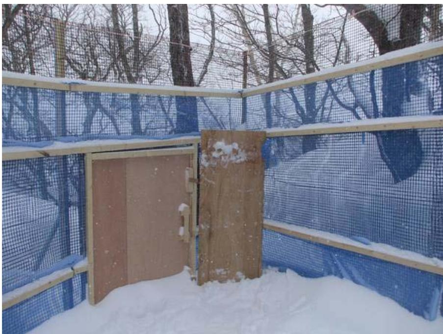
図 B-3-10. 樹脂ネット破損部の合板による修繕箇所.
