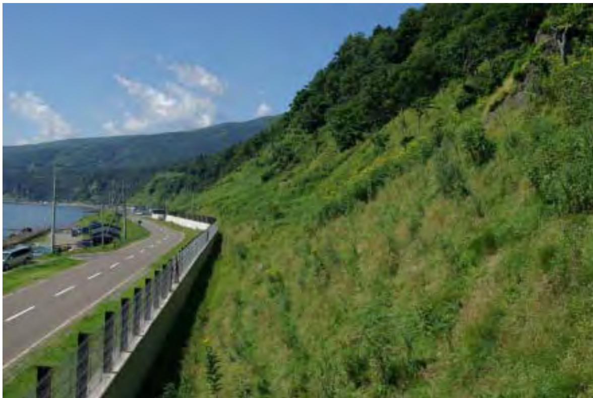
写真 37 rh31 から rh33 の概況. この 3 プロットは道路の左カーブの先にある道路右側のポール近辺に位置する. rh34 はさらに写真の先の方向に位置している (2010 年 8 月 19 日).
