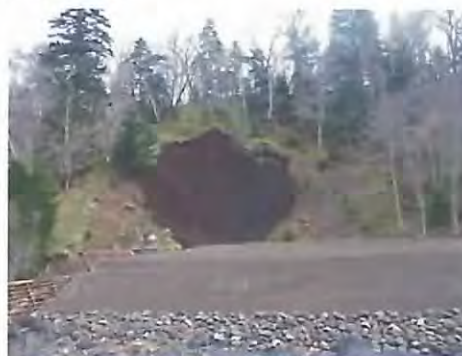
右岸の山腹法面工 (H22 年 10 月)
