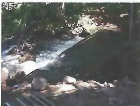
堤体部（改良工事施工前）
