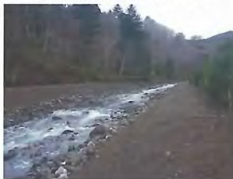
施工直後上流部の流路 (H22 年 11 月)
