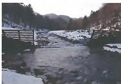
土砂流出後 (H22 年 12 月)
