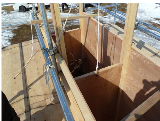
写真 2-3. 追い込み柵 (3 部屋に仕切り可)。
