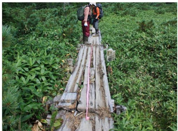
損壊・腐朽が著しい木道
