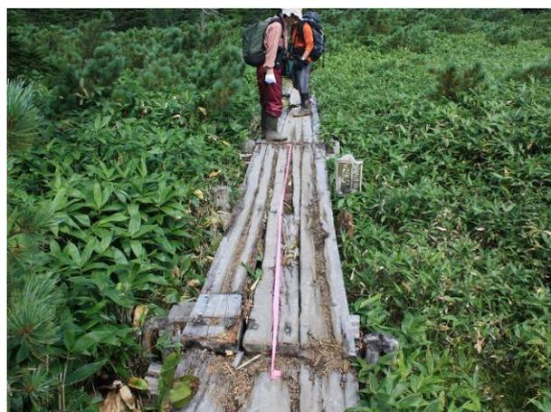
損壊・腐朽が著しい木道
