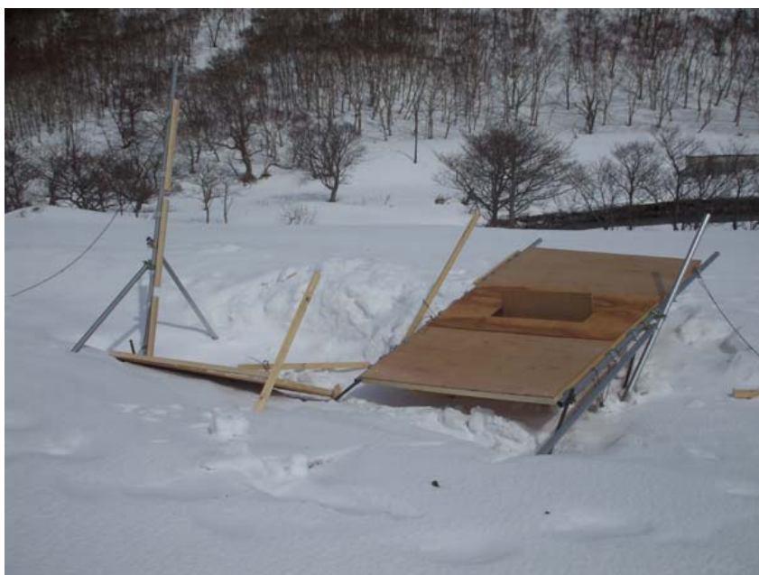
写真 19. 3月21日の暴風で破壊されたブラインド代わりの遮蔽壁（A地点，3月22日）。
