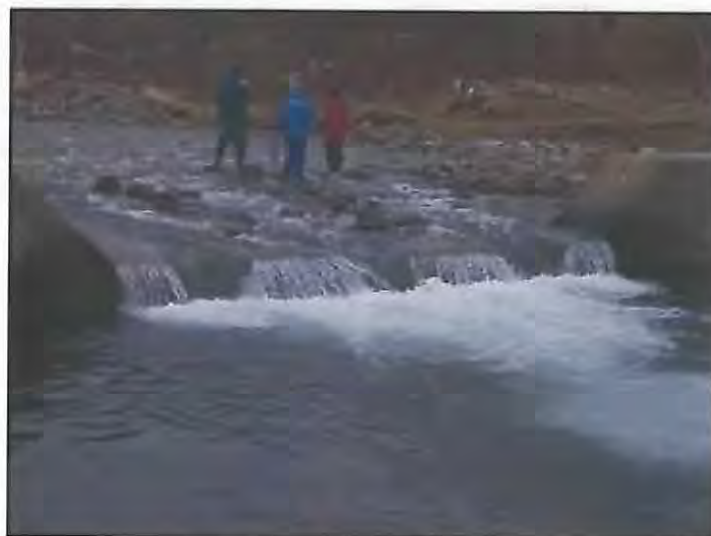
No. 2 床固工（ルシャ川）
