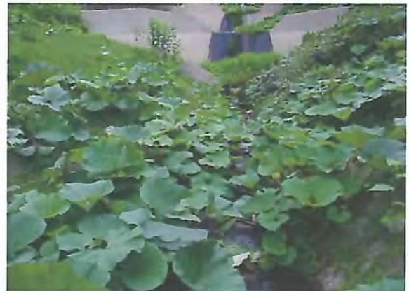
上流のブール三面張り水路工の状況。
