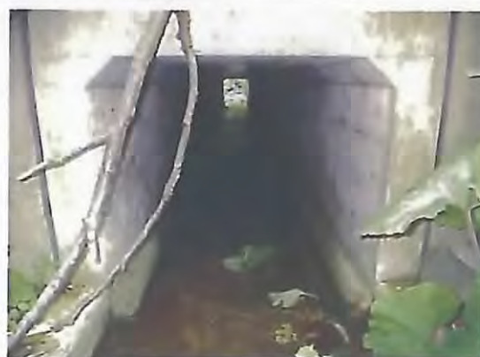
ボックスカルバート内の状況。
