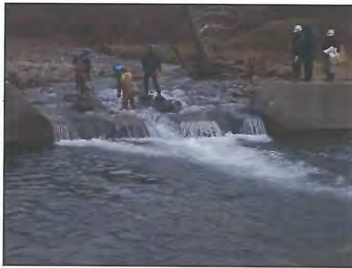
No. 1 床固工（ルシャ川）
