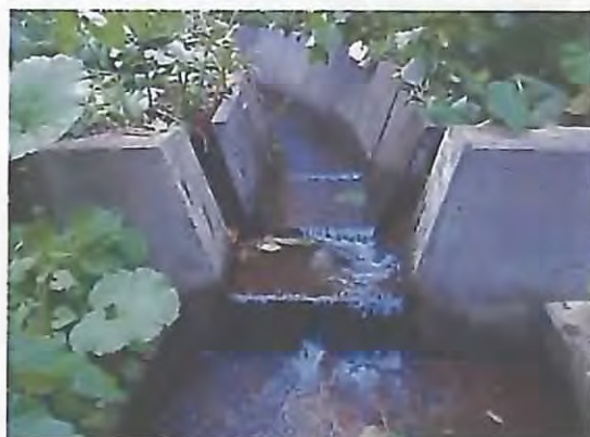
水路工起点の落差工(落差0.25m)。
