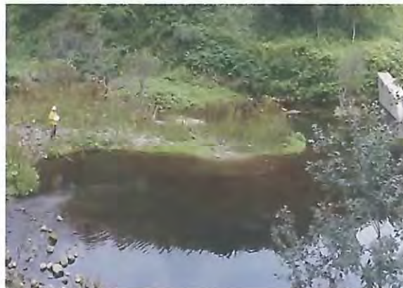
上流の土砂堆砂状況。
