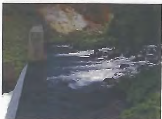
上流の土砂堆砂状況。
