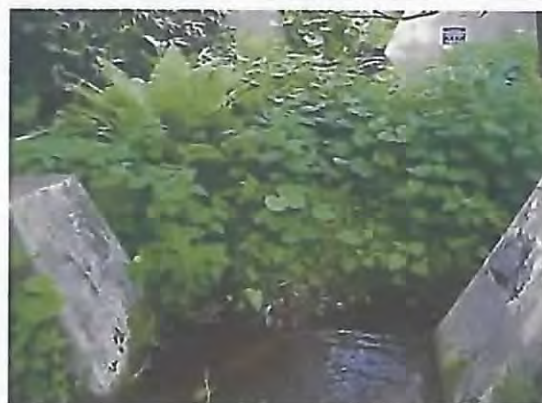
上流の土砂堆砂状況。
