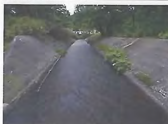
三面張水路工内の状況。
