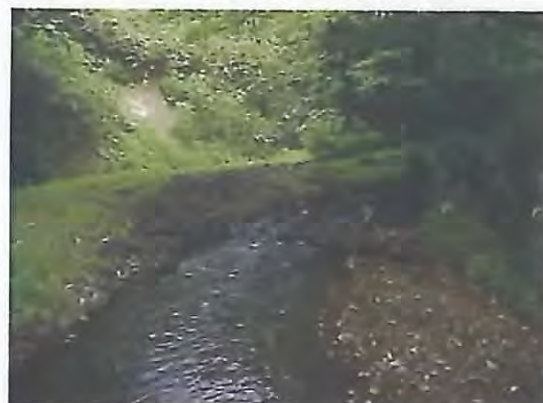
上流の土砂堆砂状況。
