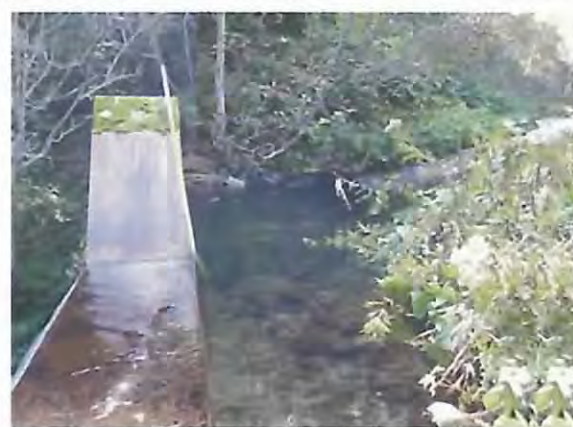
上流の土砂堆砂状況。
