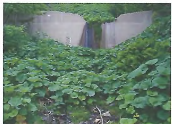
上流の土砂堆砂状況。
