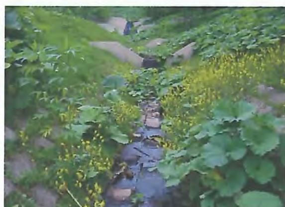
上流のブール三面張り水路工の状況。
