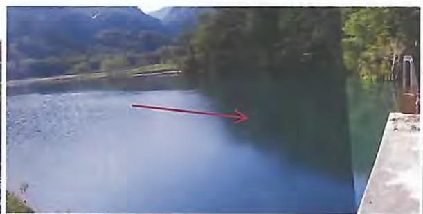
上流の土砂堆積状況。
