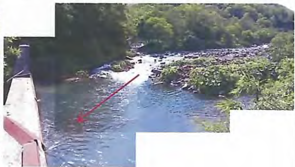
上流の土砂堆積状況。
