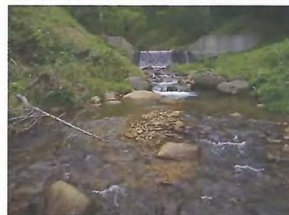
上流の土砂堆砂状況。
