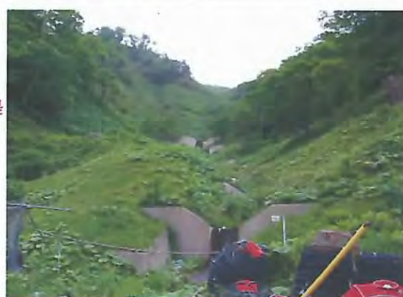
落差工の全体配置状況。
