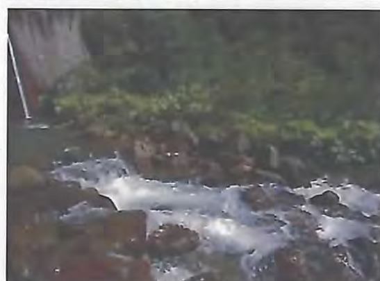
上流の土砂堆砂状況。
