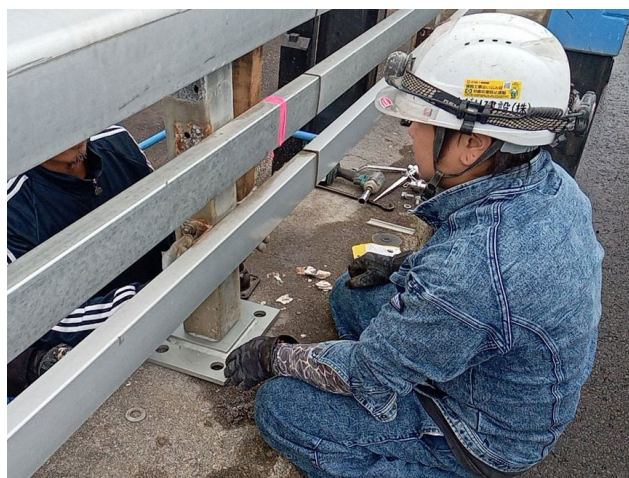
支柱取付状況
