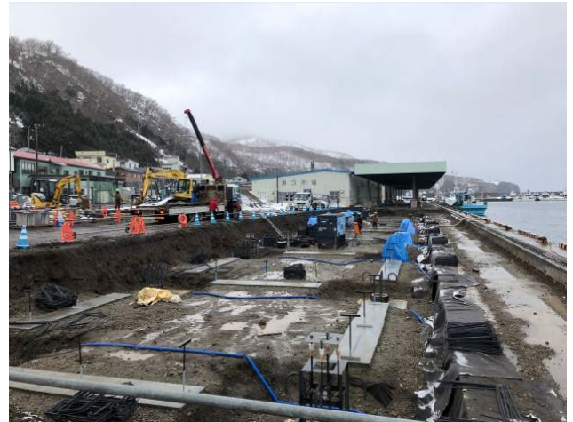
竣工後 (-4.0m 岸壁 (改良))
