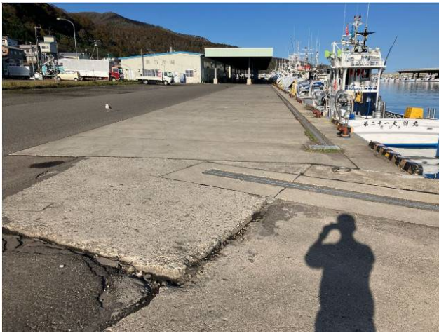
着工前 (-4.0m 岸壁 (改良))
