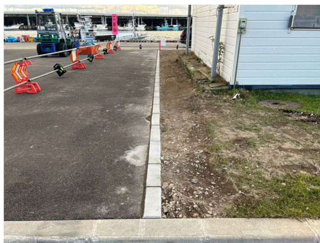
竣工後（用地(改良)）
