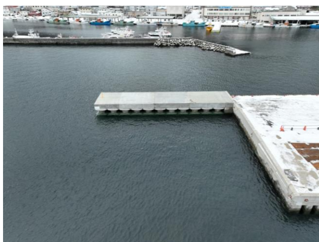
竣工後(波除堤)
