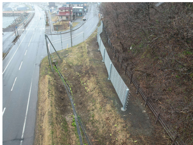
竣工後(宇登呂西工区 落石防護柵設置工)
