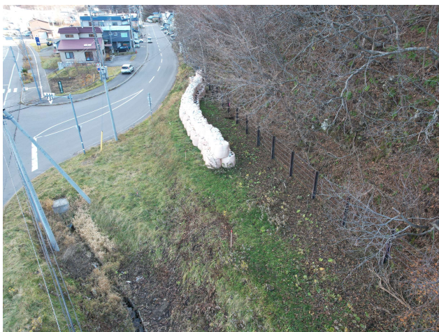
着工前(宇登呂西工区 落石防護柵設置工)
