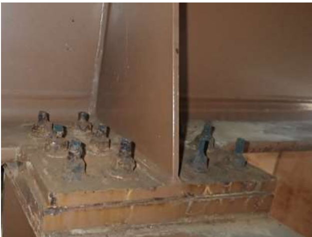
着工前(主梁ボルト交換)
