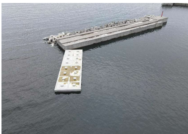
着工前(南防波堤)
