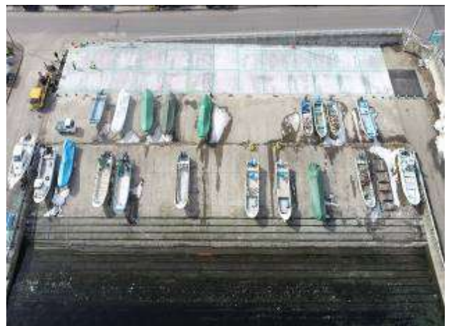
竣工後(船揚場(改良))
