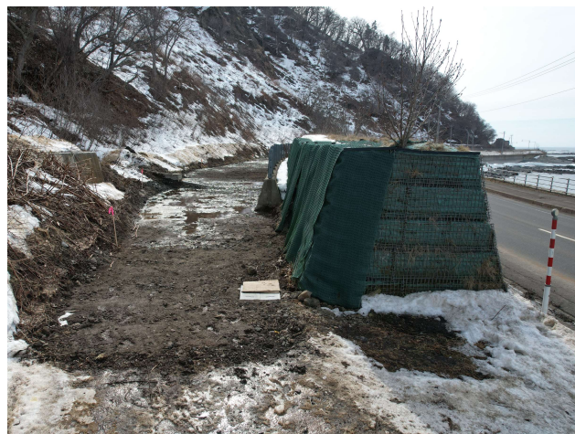
竣工後(フンベ工区 掘削工)
