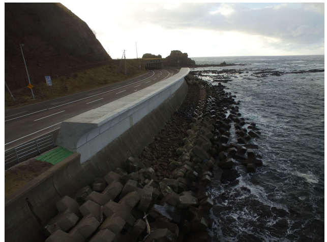
竣工後(宇登呂西工区 構造物撤去工)
