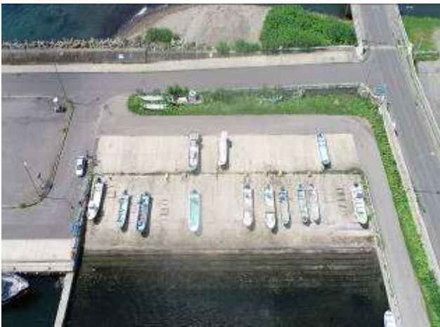
着工前(船揚場(改良))
