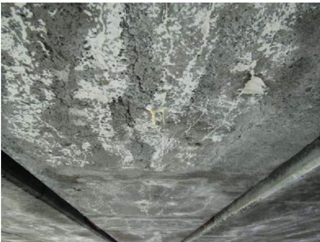
着工前(オシンコシン工区 橋梁補修工・表面被覆工)
