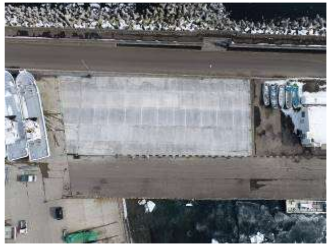
竣工後(③用地(改良))
