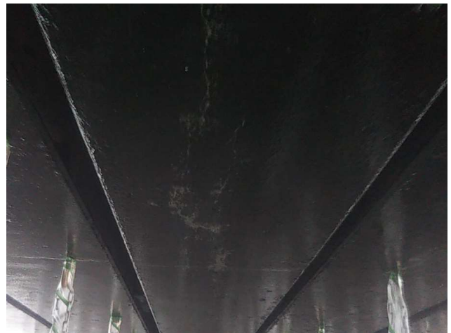
竣工後(オシンコシン工区 橋梁補修工・表面被覆工)
