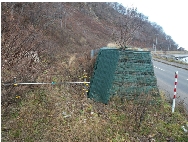
着工前(フンベ工区 掘削工)
