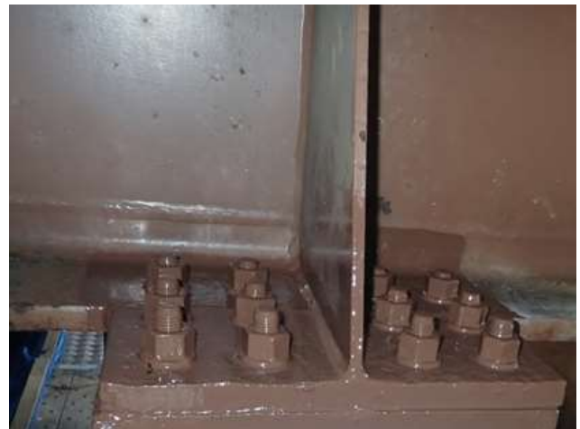
竣工後(主梁ボルト交換)
