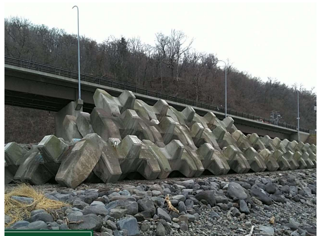
竣工後(宇登呂西工区 護岸工)
