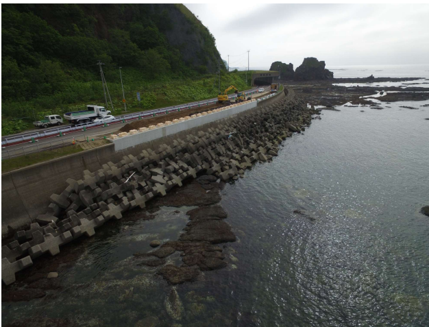
着工前(宇登呂西工区 構造物撤去工)
