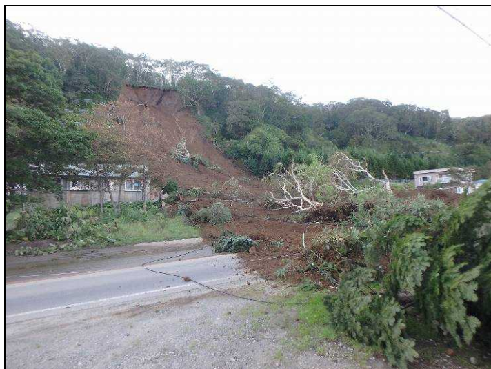
8月24日に海岸町で発生した土砂崩れの様子（写真提供：羅臼町）
