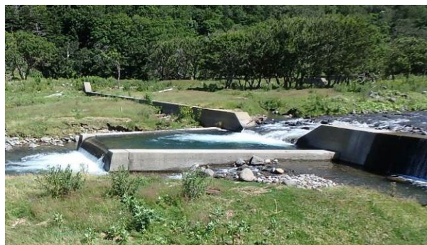
ルシャ川 No1 治山ダム（北海道）
