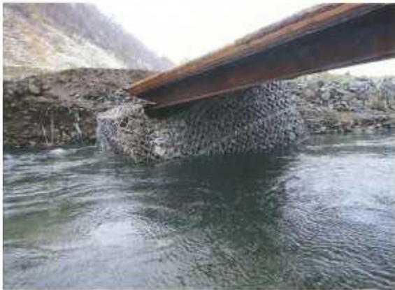
～No.2 左岸側橋台の傾斜状況～
