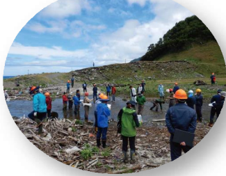
イワウベツ川7号ダムの現地検討
