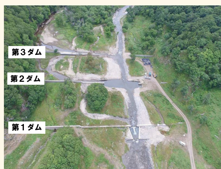
▲ルシャ川ダムの現状
