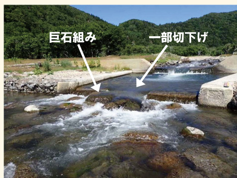
▲ルシャ川第1ダム前提の一部切下げと巨石組み
