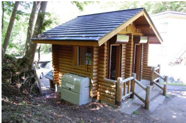
▲木下小屋トイレ横回収ボックス
