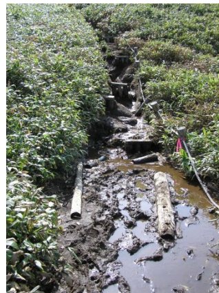
二の沼歩道浸食部の階段補修後
