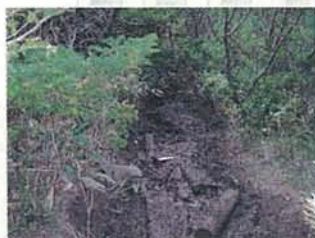
歩道のぬかるみ及び土壌浸食状況
