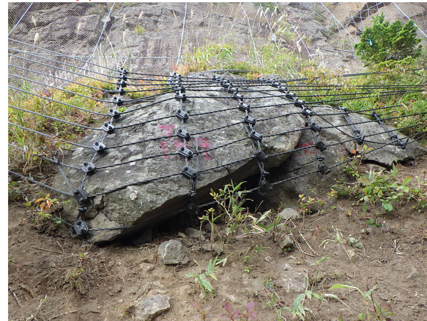
ロープ掛け工
