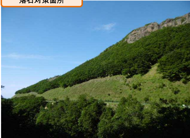
落石対策箇所
