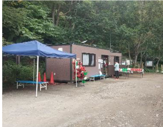
現地に設置されている管理詰所
