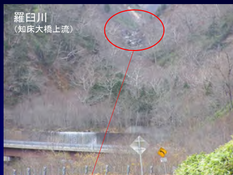
上流部に巨石が堆積しており、流下する可能性がある。
