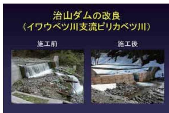
この改良は非常に簡単です。切り欠きを、これは先ほどのスリットと一緒に落としています。両端は、上流側のこの高さはもともとのダムの高さと一緒に下流側に斜めに切っています。基本的な考え方についてですが、水が飛んでしまってダムの堤体と水の流れの中に空気ができると、魚が遡上するにはジャンプするしかなくなっちゃいますね。ですから、ダム面を斜めにすることによって、ダムの表面を水が飛ばずにしっかりと流す。空気の間隙を作らずに、素直にダムのコンクリート面を斜めに流れてくれることによって、魚は尾びれを使いながら遡上できると考えそれを実施しました。魚をのぼらせるとなると、みんな魚道しか頭の中に思い浮かばないんですが、決してそんなことはなくて、ちょっとした工夫だけで、今言った水が飛ばないような状況を作つてやるだけでも十分改良は可能だと思います。
