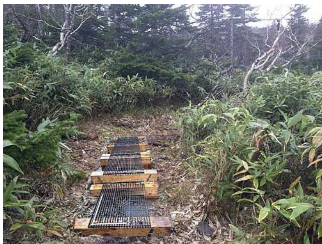
イメージ1 グレーチング敷設
